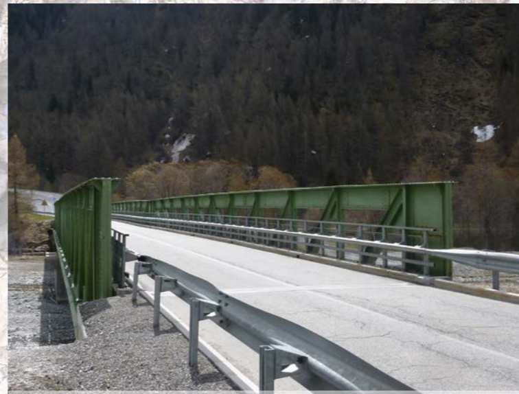
Pont sur l'Arc RD 902 - Bessans
