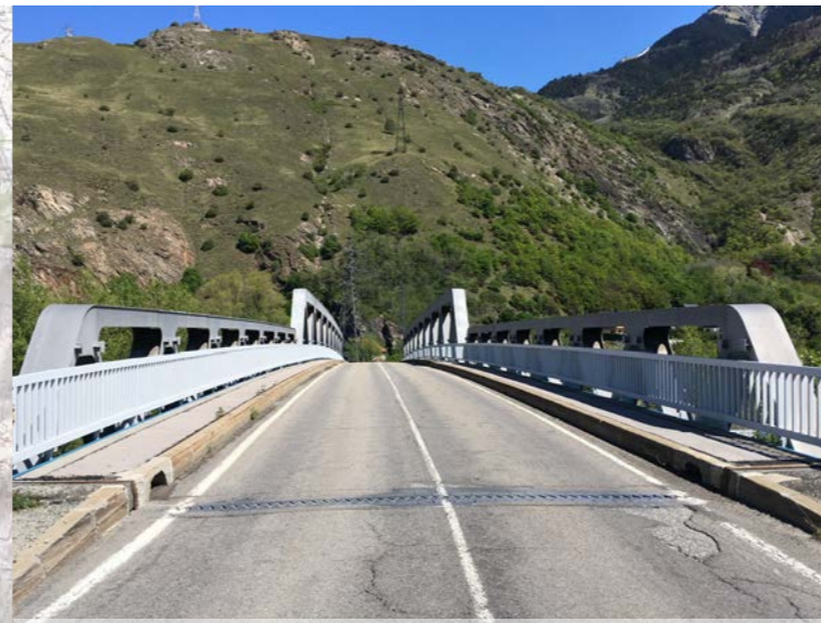
Pont sur l'Arc RD 77 - Saint-Jean-de-Maurienne
