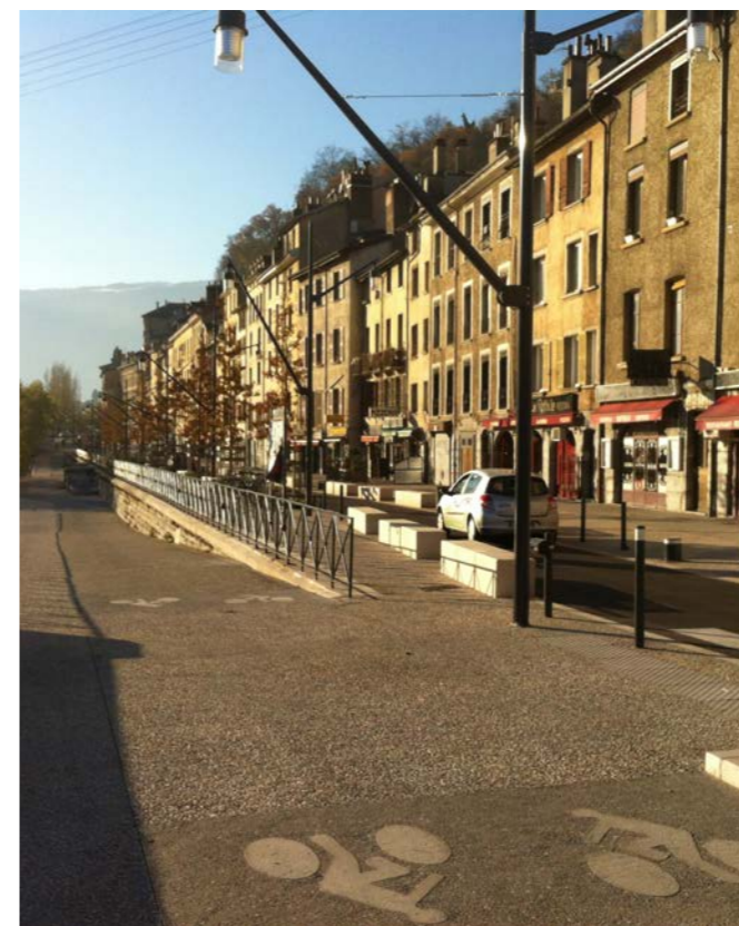
Piste cyclable en béton désactivé
